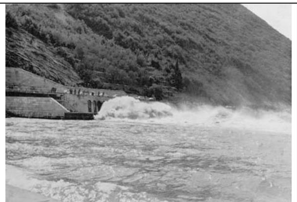
Fig. 26 - Piena dell'Adige del 1965: scarico, a Torbole, della galleria Adige-Garda ( $Q=440 \text{ m}^3/\text{s}$ ).
