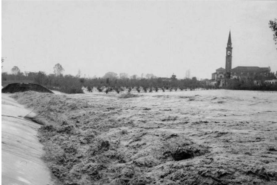
Fig. 46 - Piena del Piave del 1966: rotta in destra a valle di Ponte di Piave (Treviso).
