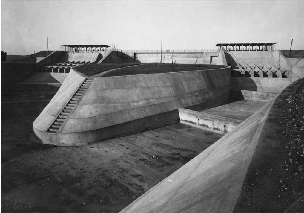
Fig. 17 - Opere d'imbocco della cassa d'espansione di Montebello Vicentino (1927).
