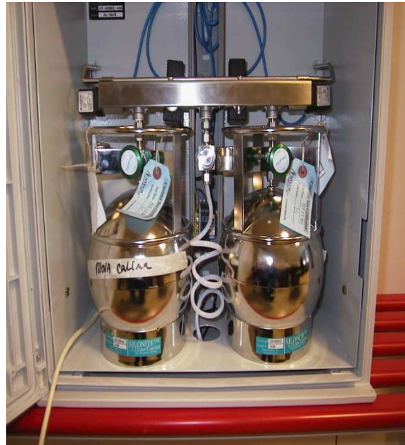
Cabina canister VOC
