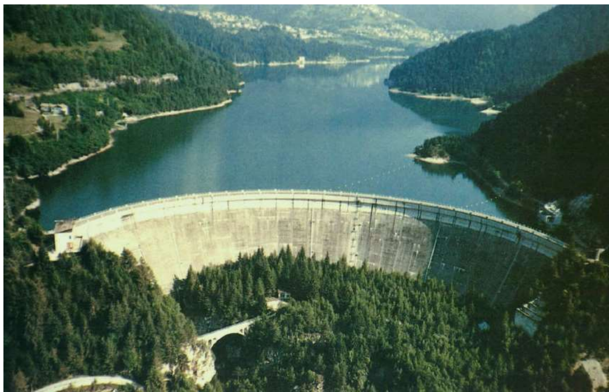
Foto 4 – Diga di Pieve di Cadore e lago di Centro Cadore (BL) (Fonte: ENEL S.p.A. – DPT, Vittorio Veneto 2000)
