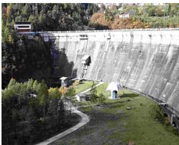
Foto 5 – Diga di Pieve di C. – Vista da valle
