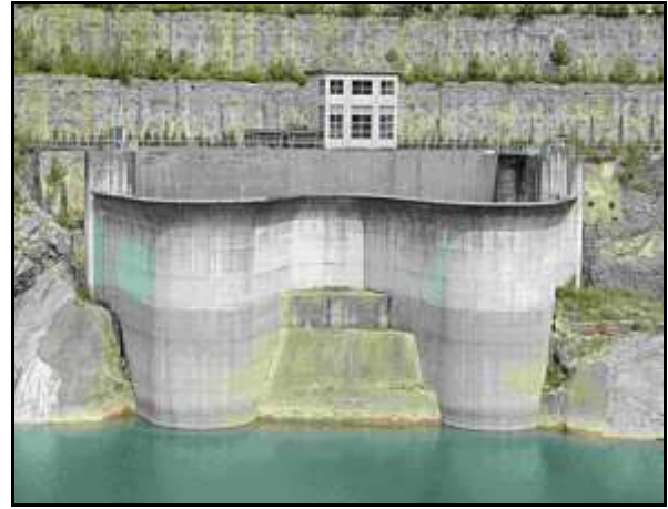
Foto 3 – Diga di Ravedis – Scarico laterale sinistro
