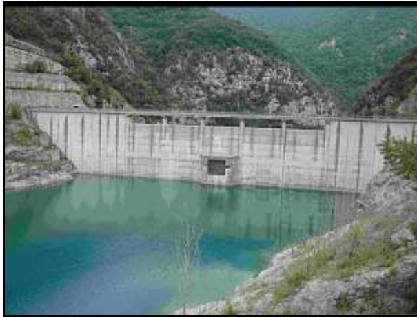
Foto 2 – Diga di Ravedis – Scarico di superficie (Vista da monte)
