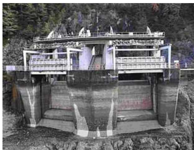
Foto 6 – Diga di Pieve di C. – Scarico di superficie
