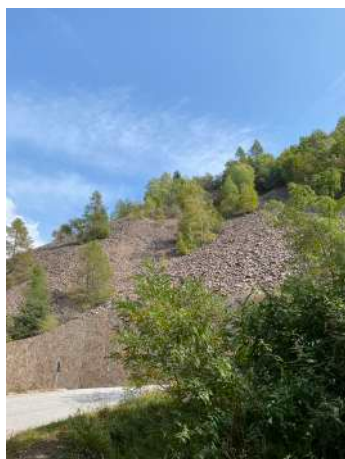
Fig X: Distesa detritica in località San Mauro, da sopralluogo eseguito in data 5/10/2023
