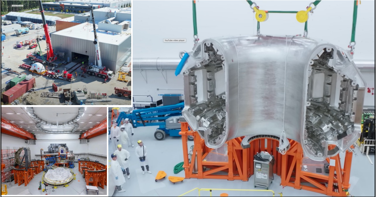
28 ott 25, arrivata la prima metà della camera a vuoto, 48 t, costruita a Chieti
