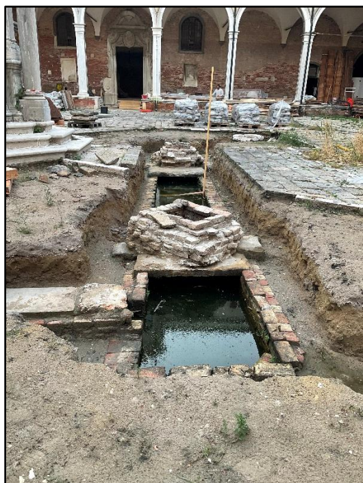
I lavori al chiostro e al pozzo di S. Antonio
