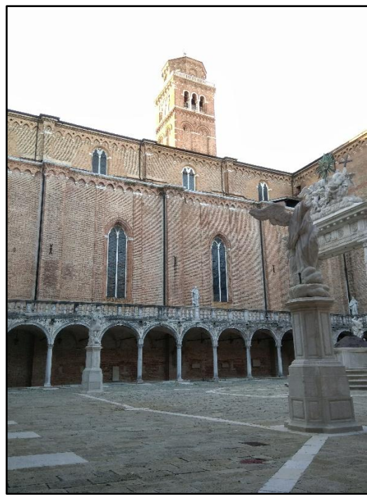
Il campanile sullo sfondo del chiostro
