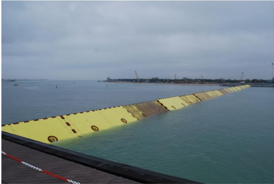
*Figura 13: Sistema Mo.S.E. attivo (foto presa da [www.mosevenezia.eu/sistema-mose-sollevata-tutta-la-schiera-di-21-paratoie-a-lido-nord](http://www.mosevenezia.eu/sistema-mose-sollevata-tutta-la-schiera-di-21-paratoie-a-lido-nord))*
