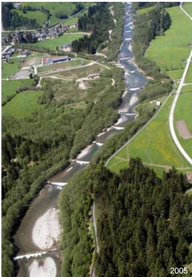
Prima dei lavori
