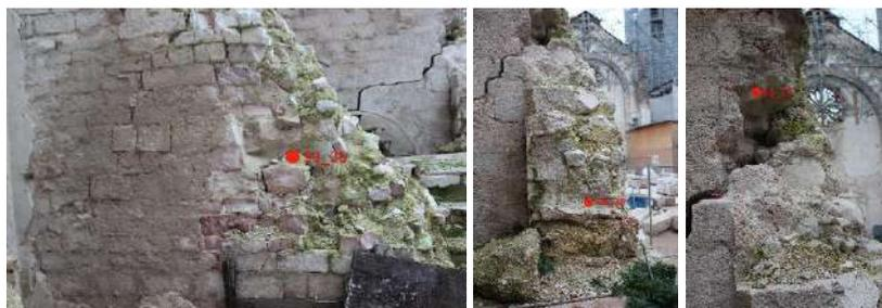
Figura 76 - Campionamenti eseguiti alla base del campanile: SB\_35 (sinistra), SB\_36 (centro), SB\_37 (destra)
