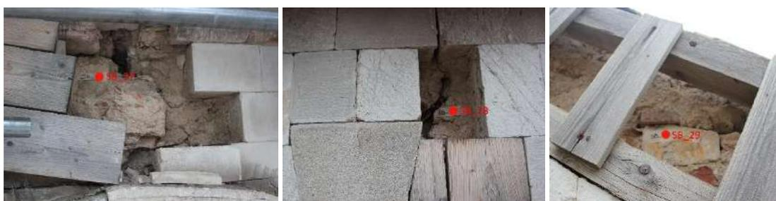
Figura 73 - Campionamenti eseguiti in facciata: SB\_27 (sinistra), SB\_28 (centro), SB\_29 (destra)
