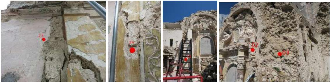
Figura 67 – Campionamenti eseguiti sul muro della navata sinistra: SB\_23, SB\_24, SB\_01, SB\_02 e SB\_03 (da sinistra a destra)
