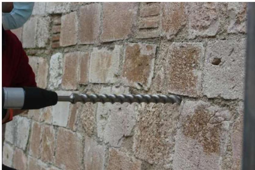
Figura 126 - Esecuzione foro d'ispezione per indagine con endoscopio nel transetto della Basilica di San Benedetto
