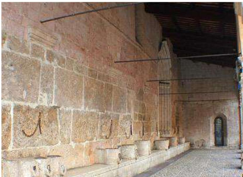
Figura 32 – Portico delle Misure, individuazione delle due diverse tipologie di muratura [ICCD]
