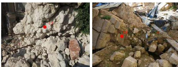
Figura 72 – Campionamenti eseguiti su cella campanaria crollata: SB\_17 (sinistra) e SB\_18(destra)
