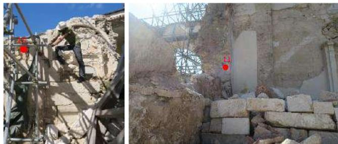
Figura 68 - Campionamenti eseguiti sul muro della navata destra: SB\_01 (sinistra), SB\_11 (destra)
