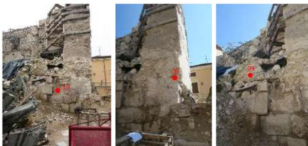
Figura 71 - Campionamenti eseguiti nel campanile: SB\_19 (sinistra), SB\_08 (centro), SB\_09 (destra)
