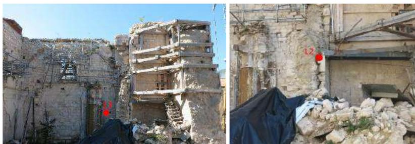
Figura 70 - Campionamenti eseguiti sul transetto destro (SB\_13, sinistra), e sul muro di contatto con il campanile (SB\_12, destra)
