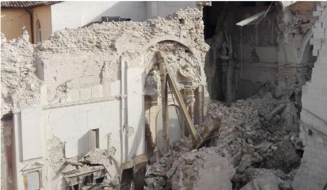
*Figura 198 - Dettaglio finestra tamponata e archi, immediato post sisma 30 ottobre [DIP, 2020]*
