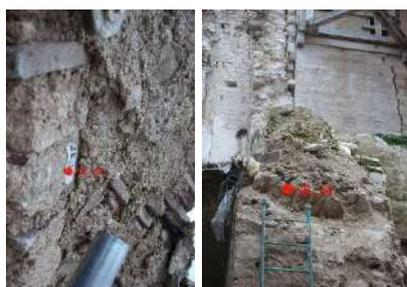
Figura 77 - Campionamenti eseguiti nell'arco trionfale dell'abside (SB\_38, sinistra) e alla base dell'arco trionfale presente tra navata e transetto (SB\_34, destra)
