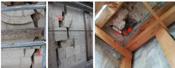
Figura 75 - Campionamenti eseguiti nel campanile SB\_32 (sinistra), SB\_33 (centro) e nella nicchia esterna del transetto SB\_30 (destra)
