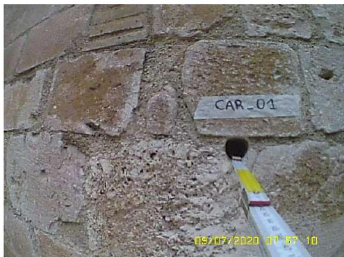
Figura 128 - Foto del carotaggio CAR\_01 dall'esterno
