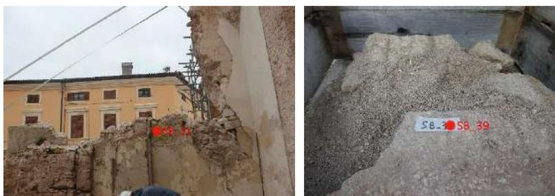
Figura 74 - Campionamenti eseguiti nel muro della navata destra (SB\_31, sinistra) e nella base di una colonna del Portico delle Misure (SB\_39, destra)
