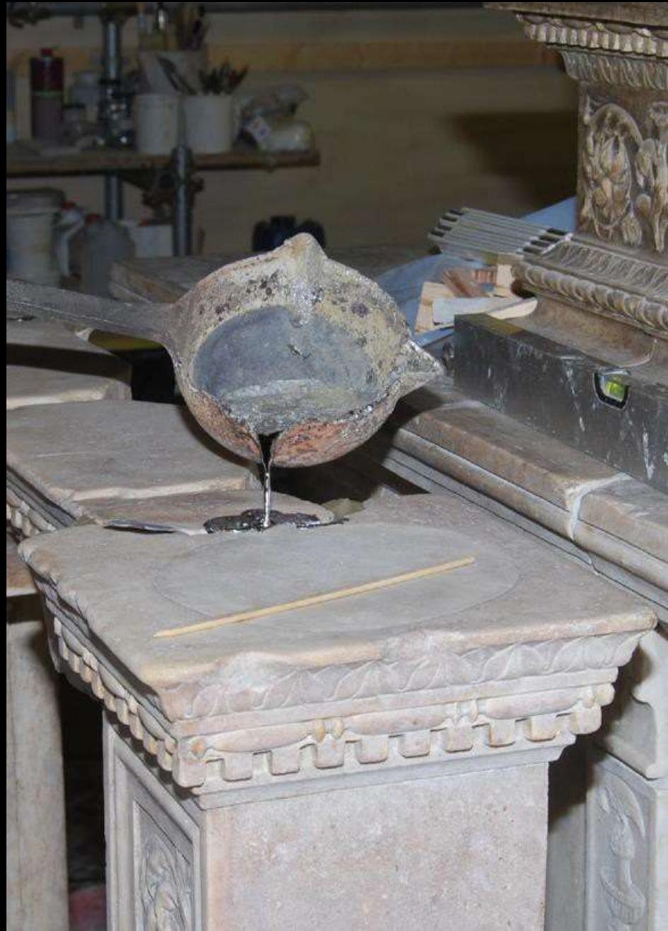
Gli elementi rimontati dopo la desalinizzazione in vasca con acqua deionizzata
