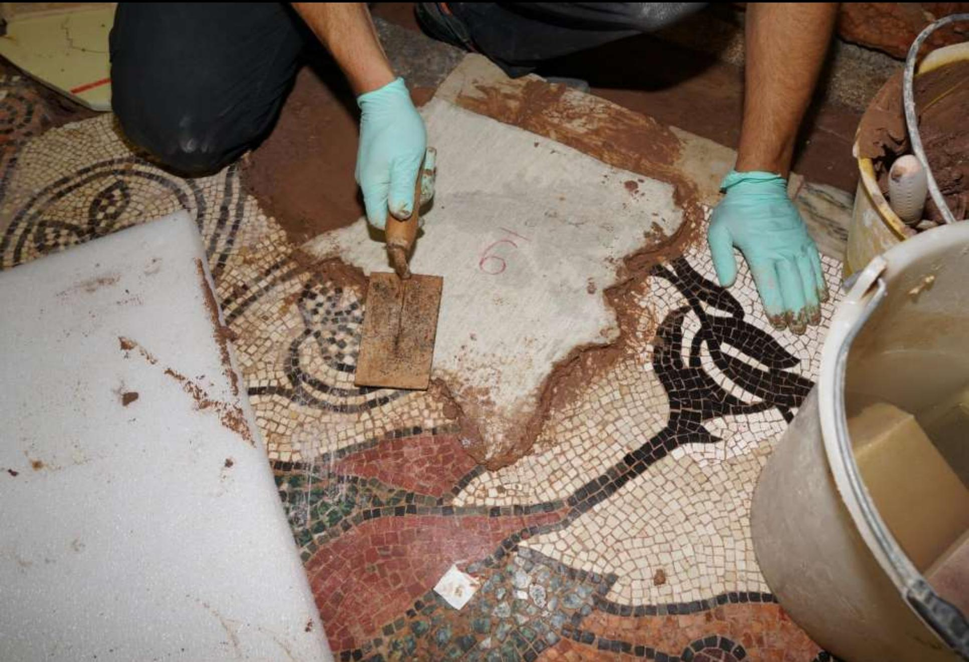
Fase di rimozione dell'intelatura di una sezione di pavimentazione tessulare
