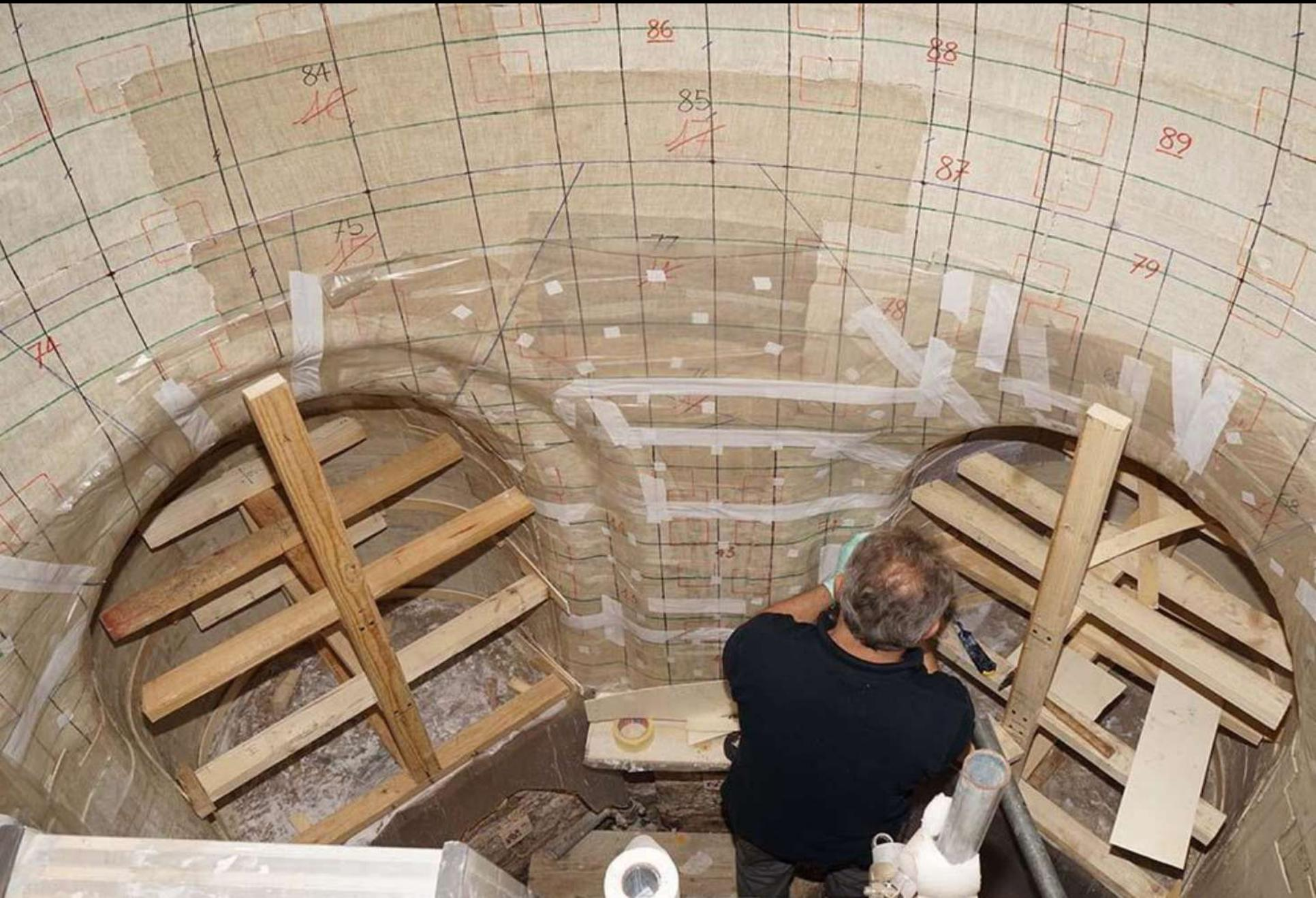
Rimozione di una delle 5 parti di controsagoma usate per la realizzazione della calotta
