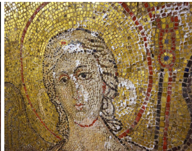
Le efflorescenze saline su un tratto di mosaico dovute alla risalita capillare
