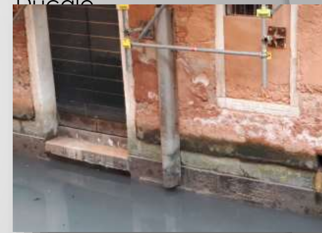
Interventi di presidio delle porte d'acqua già realizzati da Generali (+1.75 cm z.m.p.s.)
