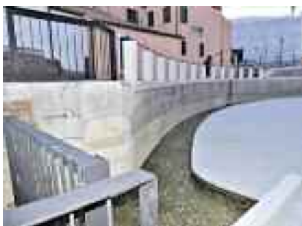
Vista da sud Canaletta ovest
