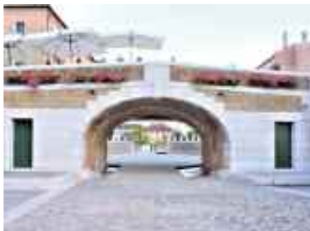
Vista generale da Piazza Cantiere
