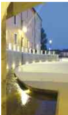
Lato e canaletta est
