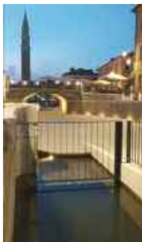
Inizio canaletta ovest
