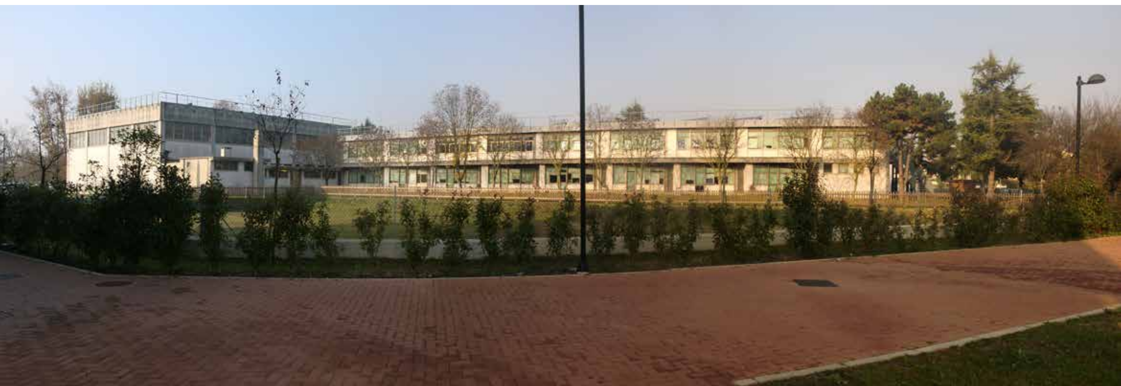
Vista panoramica bacino per l'invarianza idraulica e edificio scolastico di Olmo
