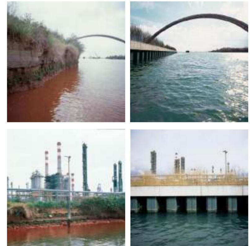
Fig 3.8 messa in sicurezza dei siti inquinati e rifacimento delle arginature lungo il Canale dell'Industria Sud, foto prima e dopo l'intervento, [www.mosevenezia.eu](http://www.mosevenezia.eu)
