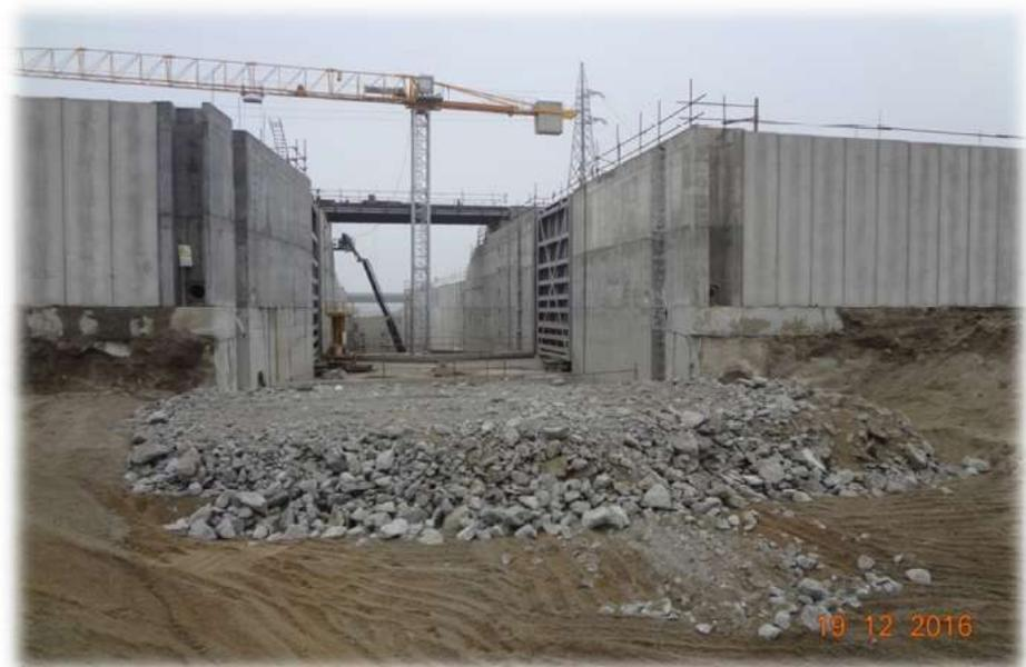
Gennaio 2017: demolizione testata di valle della conca
