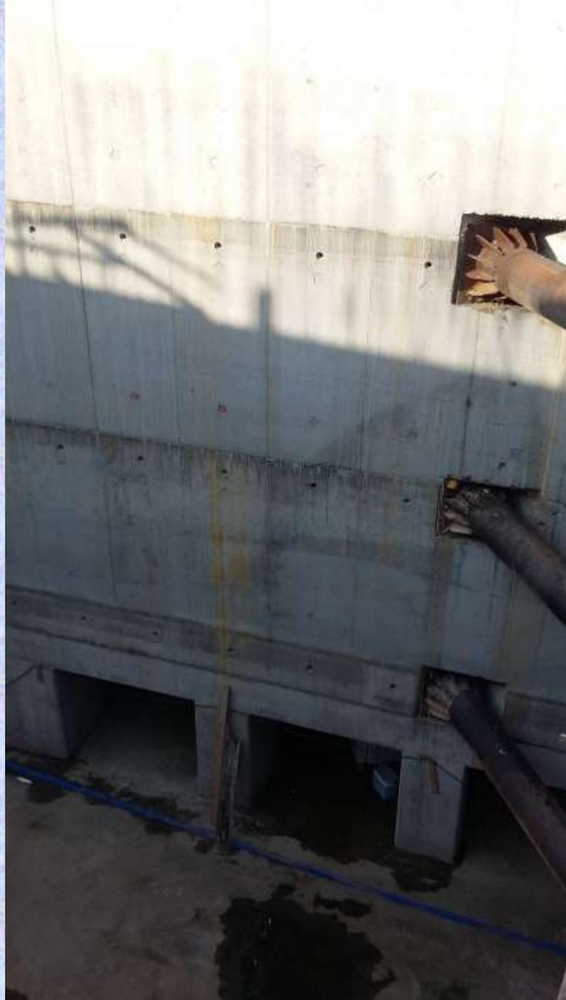
Dicembre 2016: demolizione struttura in c.a. testata di monte
