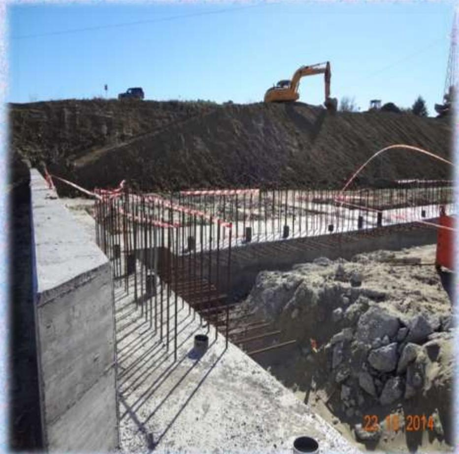
nel periodo in oggetto l'avanzamento delle opere civili è al 70% della totalità della struttura, precisamente si è raggiunta la quota finita di +45,00 sino all'altezza del concio 6.
