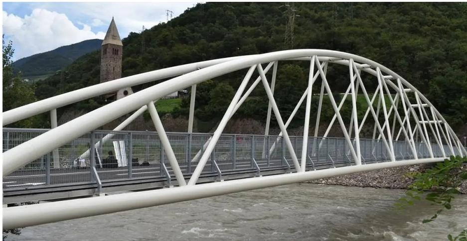
*Figura 16 - Ponte sul fiume Isarco a Campiglio, Bolzano: pendini con profili d'acciaio*
