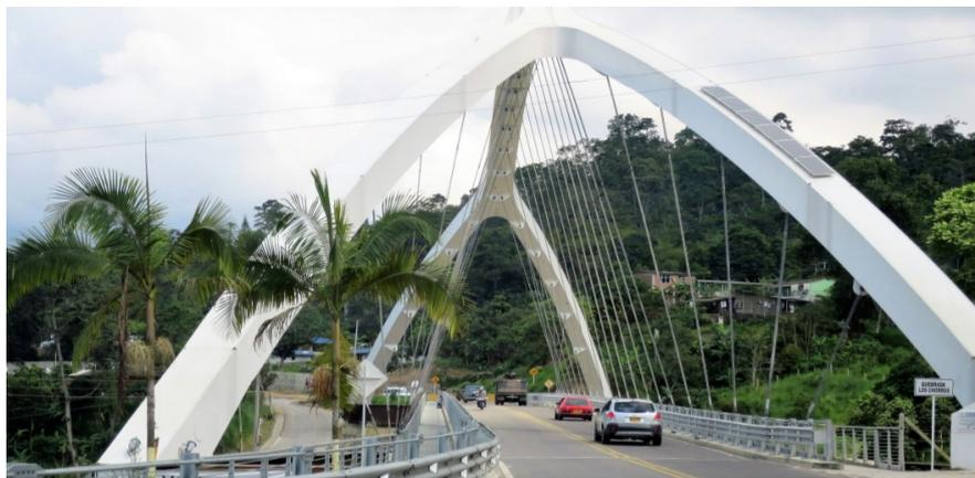
*Figura 20 - Ponte ad arco centrale che si apre verso le imposte [16]*
