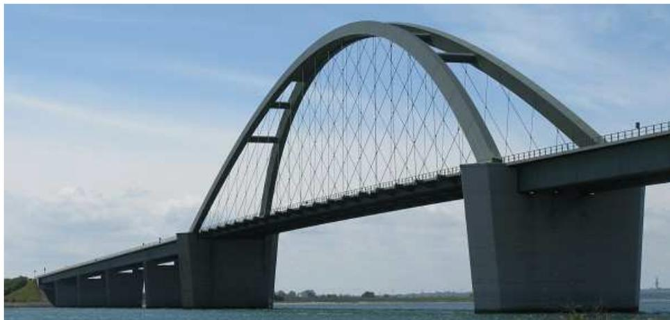
Figura 13 - Ponte Fehmarnsund, Germania: sistema Network [22]
