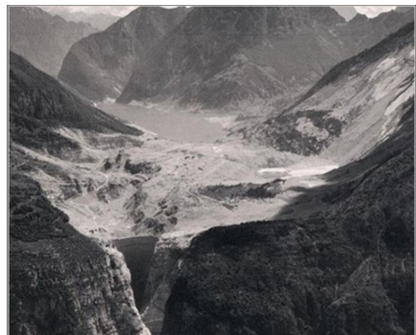
Foto 4 - Cosa restava del serbatoio del Vajont, poco dopo la caduta della frana (1963).
