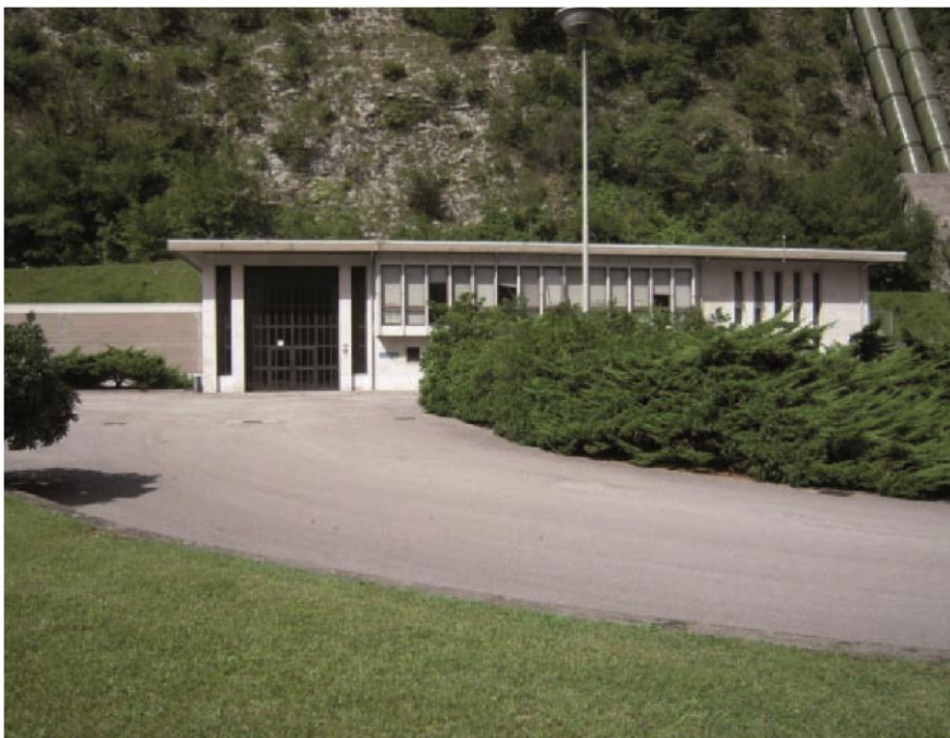
Figura 8. Portone di accesso alla centrale di Nove '71. Le condotte forzate sullo sfondo sono le condotte di Nove '25
