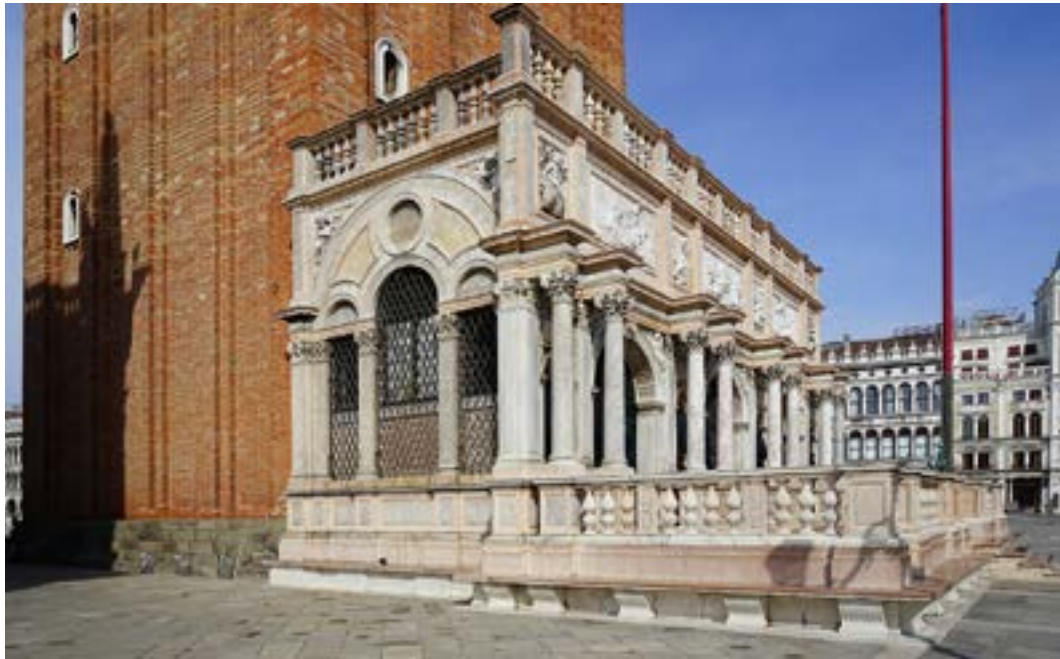
Figura 21 – La loggetta sansoviniana a intervento concluso.
