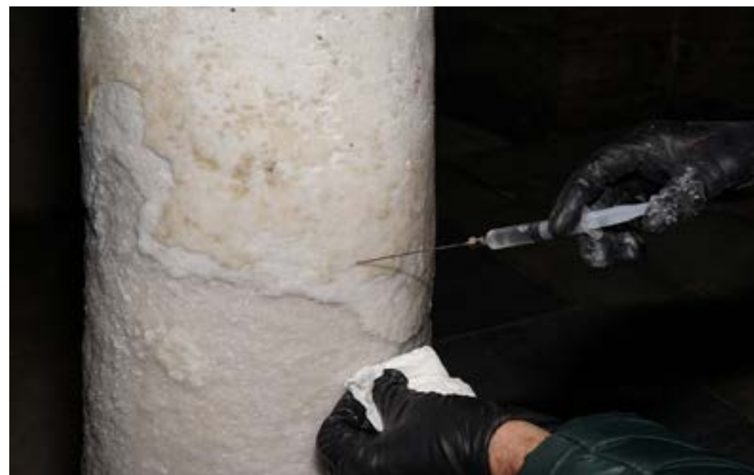
Figura 2 – Iniezione di consolidamento del fusto di una colonna della cripta.
