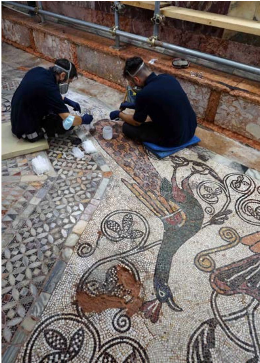
Figura 5 – Applicazione di bendature d’urgenza delle aree della pavimentazione in opus tessellatum dei pavoni compromesse dalla grande invasione mareale del novembre 2019.
