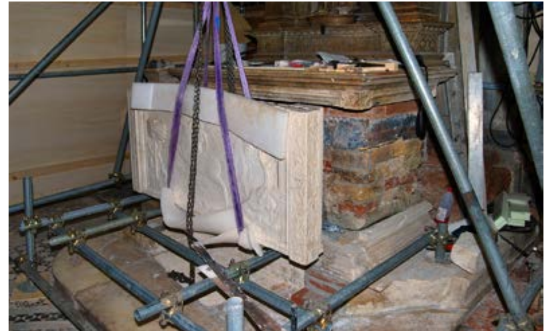
Figura 6 – L’antependio dell’altare di San Paolo, desalinizzato in vasca con acqua distillata, in fase di rimontaggio.
