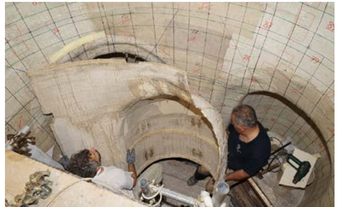
Figura 7 – Rimozione di un tratto della controsagoma delle superfici mosaicate della Tomba Falier, utilizzata per la formazione della calotta in vetroresina che accoglierà i mosaici restaurati.
