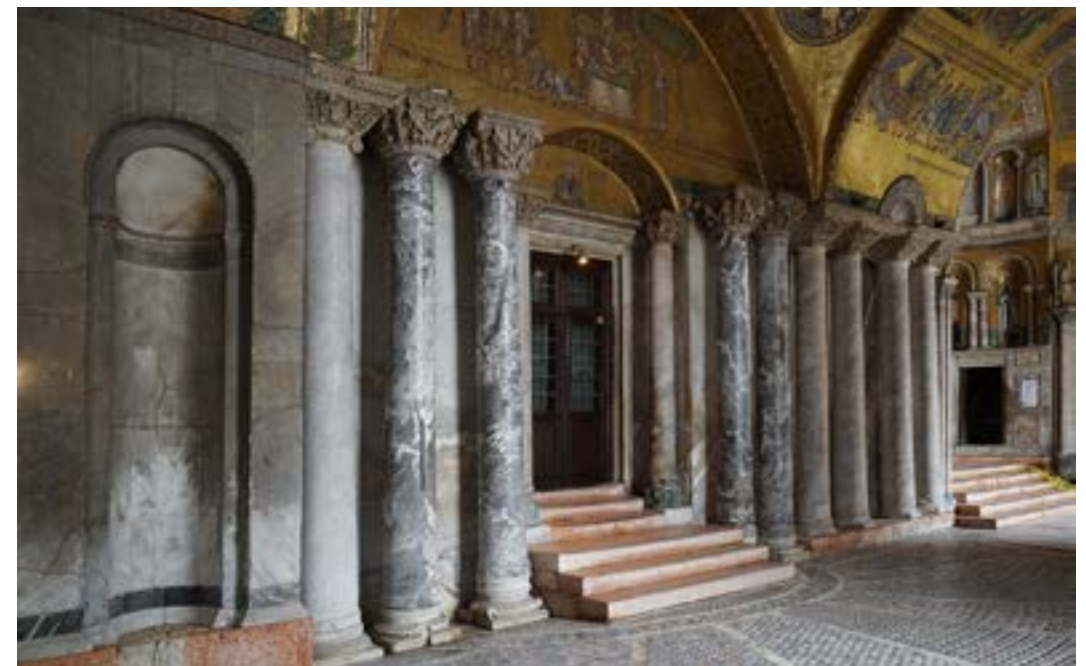
Figura 15 – Le quattro colonne in marmo d'Aquitania del portale di San Pietro, a restauro ultimato.
