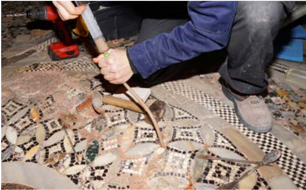
Figura 3 – L'esecuzione di un'iniezione di intasamento di un vuoto sottostante la pavimentazione.
