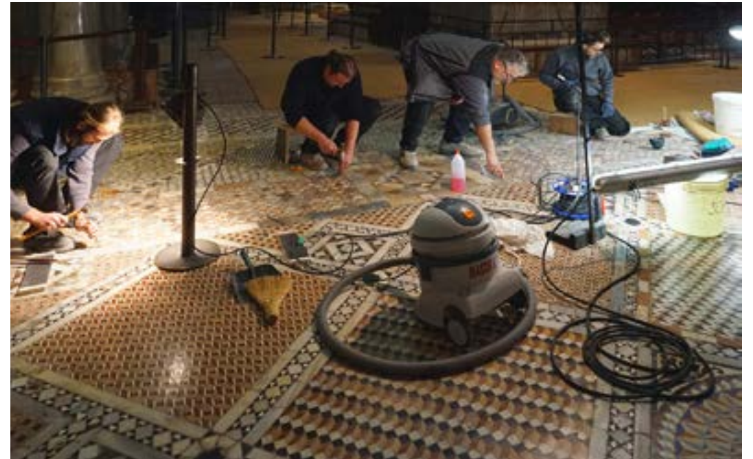
Figura 4 – Interventi d'urgenza sulle aree pavimentali compromesse dalla grande invasione mareale del novembre 2019.
