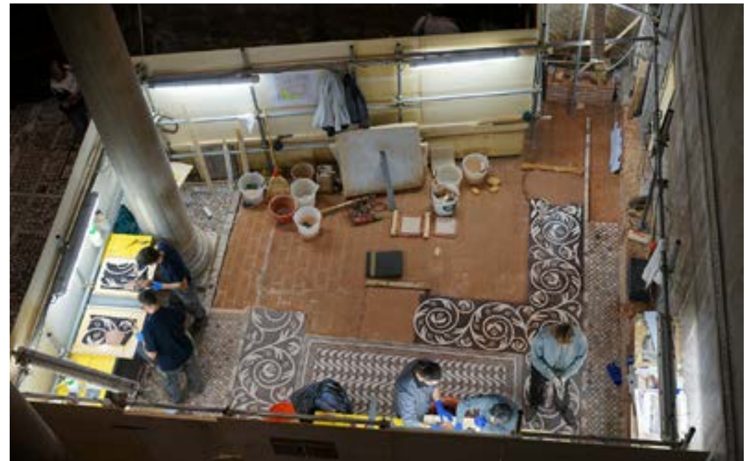
Figura 11 – Il tappeto pavimentale in opus tessellatum antistante la Stanza del Tesoro in fase di rimontaggio.
