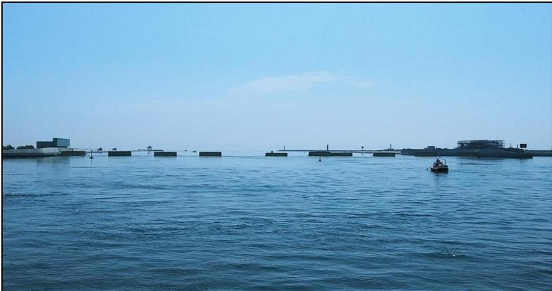
**Fig. 6 - Mo.S.E.: la barriera di Malamocco in fase di chiusura (ore 11:30 del 10-VII-2020)**
