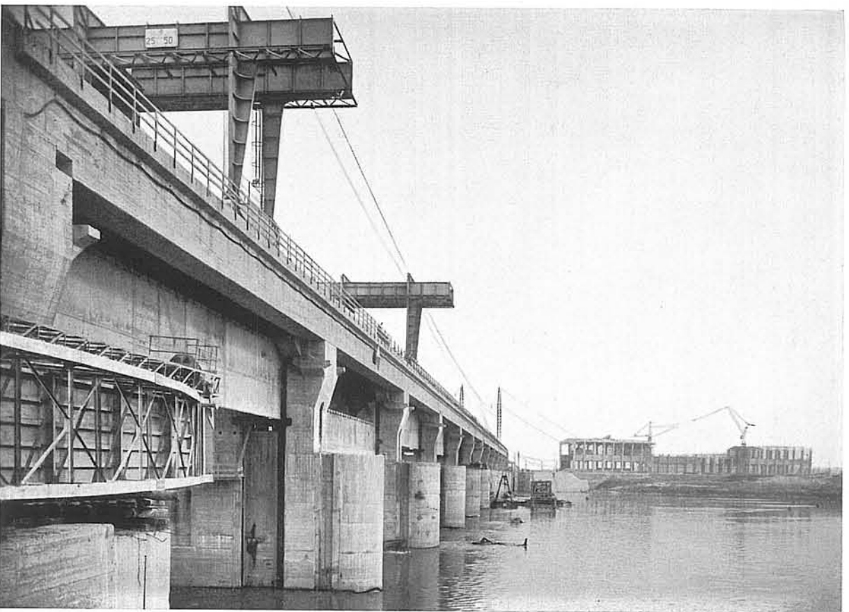
Dam - General view from upstream left bank; in the background the power-house building - February 1961 Barrage - Vue totale d'amont côté rive gauche; sur le fond le bâtiment de la centrale - Février 1961
